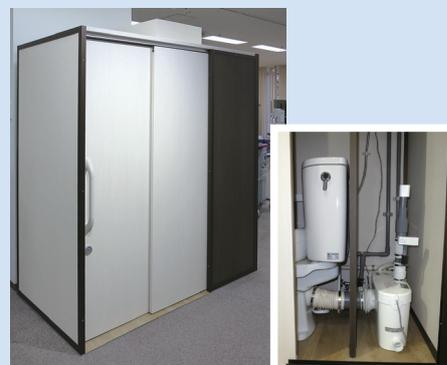
**【仕様】**・化粧銅板パネル構造・水こぼれ対応床・手洗い（標準型：手洗い一体型、車いす対応型：洗面台、小型：なし）・便器・圧送ポンプ（満水警報器付）・換気扇連動LED照明・手すり（車いす対応型はL字手すり、折上げ式手すり）・ペーパーホルダー、鏡（車いす対応型）（洗浄便座はオプション）
